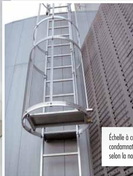
Échelle à crinoline munie d'une condamnation grillagée de type C selon la norme NF E85-010
