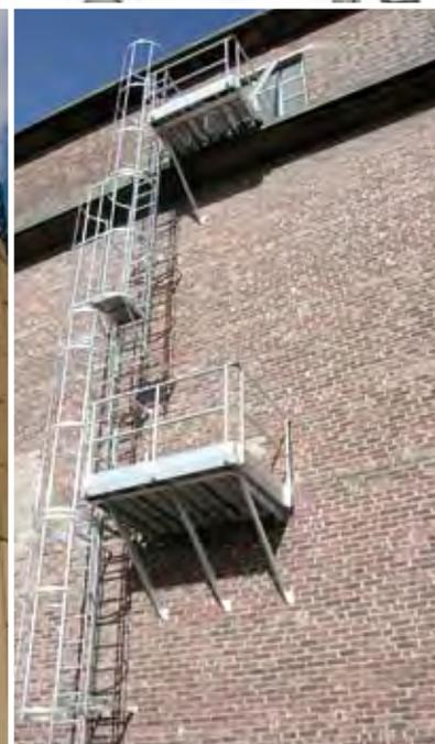
Sortie d'échelle par passerelle avec portillon de sécurité
