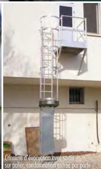
Crinoline d'évacuation avec sortie sur palier, condamnation entrée par porte
