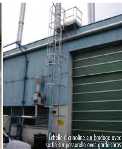
Échelle à crinoline sur bardage avec sortie sur passerelle avec garde-corps
