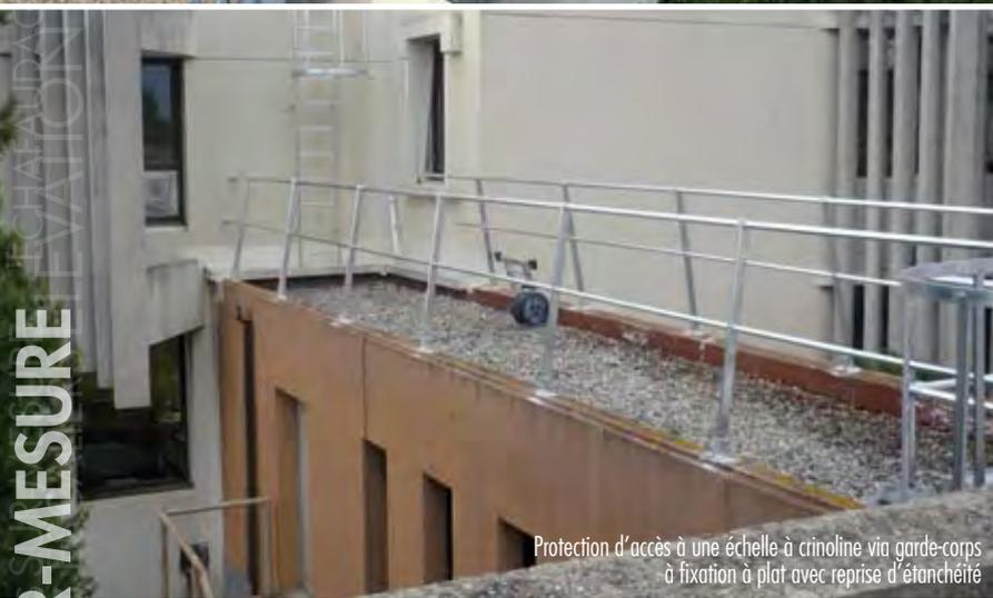
Protection d'accès à une échelle à crinoline via garde-corps à fixation à plat avec reprise d'étanchéité
