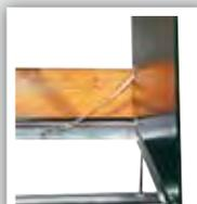
Trappes d'accès équipées d'une sangle servant de limitation d'ouverture.
