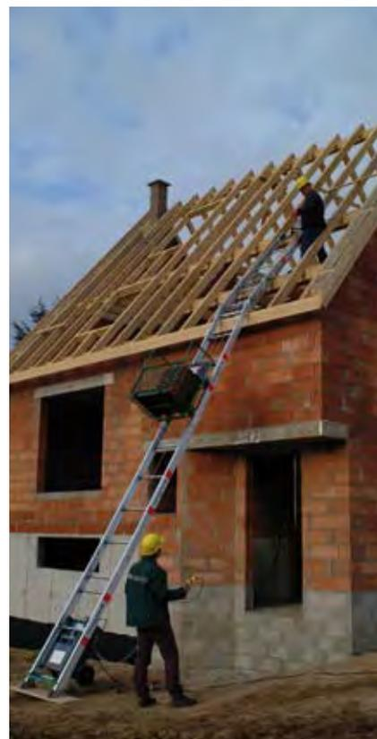
Bac à double basculement version maçon
