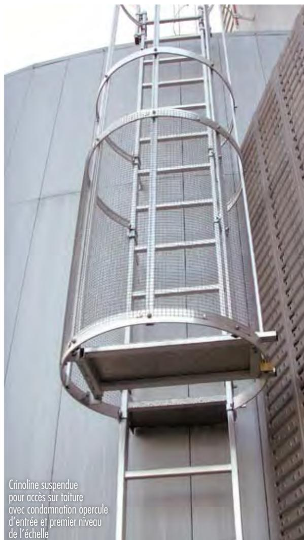
Crinoline suspendue pour accès sur toiture avec condamnation opercule d'entrée et premier niveau de l'échelle
